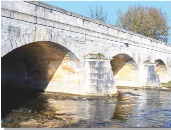
Bögen der Brücke
