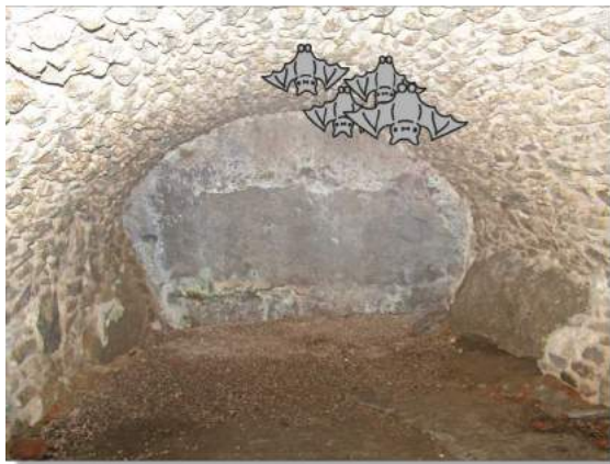
Gemauertes Kellergewölbe
