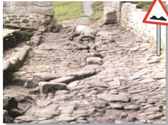
Fundzustand der Pflasterung im inneren Burghof 2
