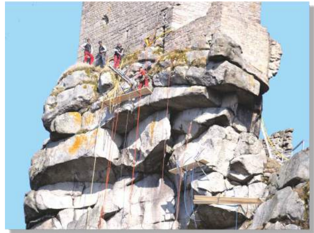
Sicherungsarbeiten an den Felsen 2022
