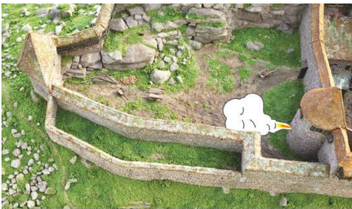
Äußerer Burghof ③, doppelte Ringmauer und Batterieturm
