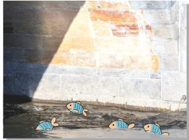
Granitquader am Pfeiler der Brücke
