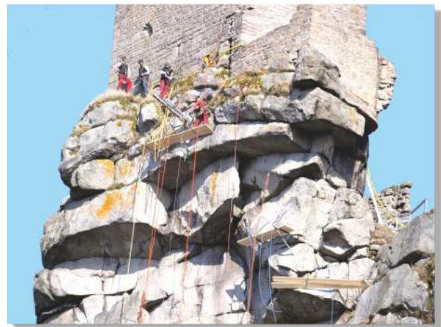
Sicherungsarbeiten an den Felsen 2022
